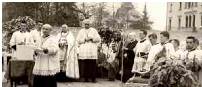
7 aprile 1949 don Giuseppe Carraro in primo piano alla posa della prima pietra della ricostruzione ed ampliamento del Seminario
