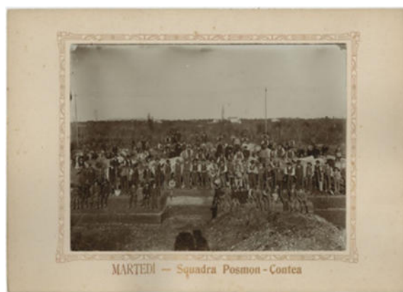
Fig. 52. Fotografo non identificato, [Costruzione della nuova chiesa di Montebelluna]. Martedì - Squadra Posmon-Contea , 1908-1909, aristotipo, mm 177x235 / 242x342 (000191).
